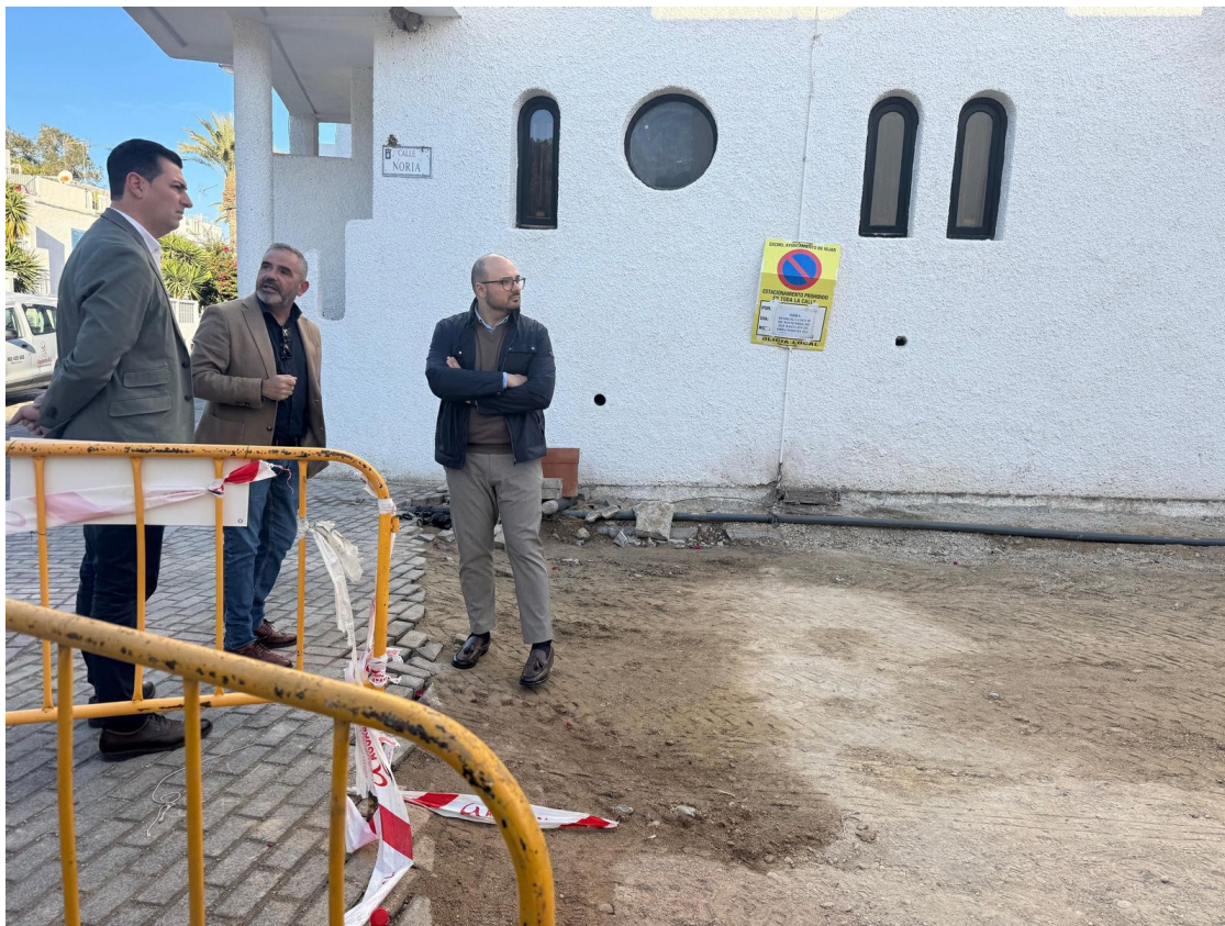
Visita institucional a las calles de Agua Amarga que están siendo renovadas.
