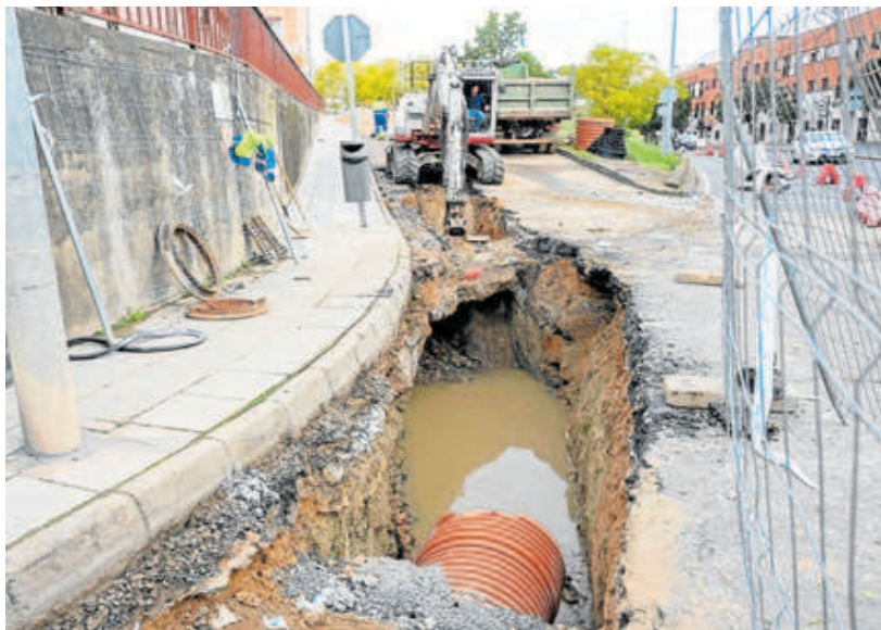
Se ha abierto una zanja en la calle Coimbra y el vial que baja de Legado de Macías. JOSÉ VICENTE ARNELAS
